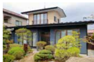
外壁から解体して組み直したので、 断熱と耐震は最新仕様
